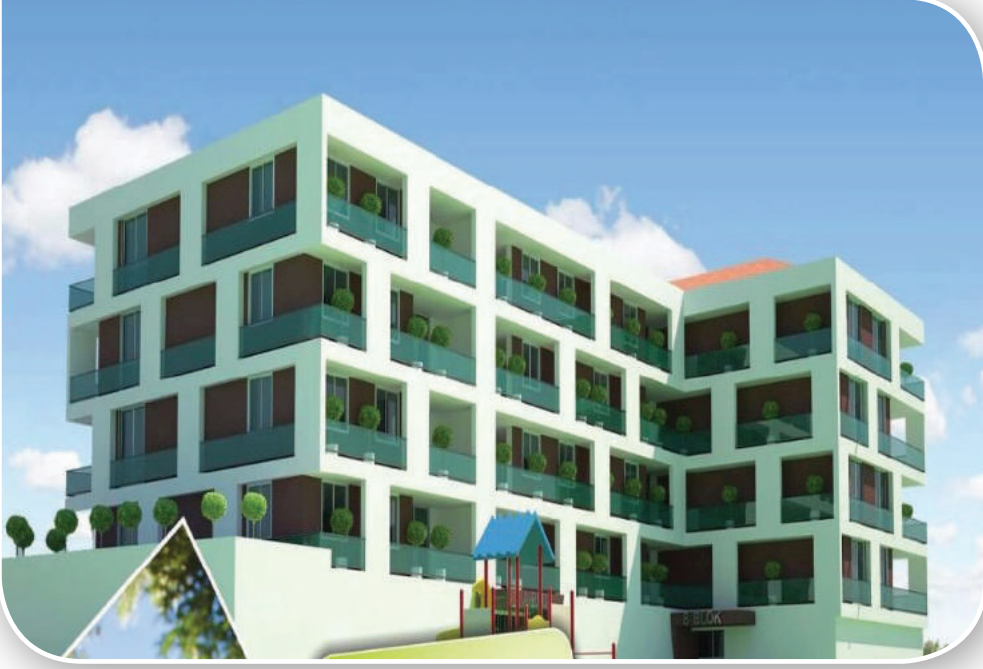
Hüseyin Durmaz İnşaat \ Saklı Bahçe Konutları
