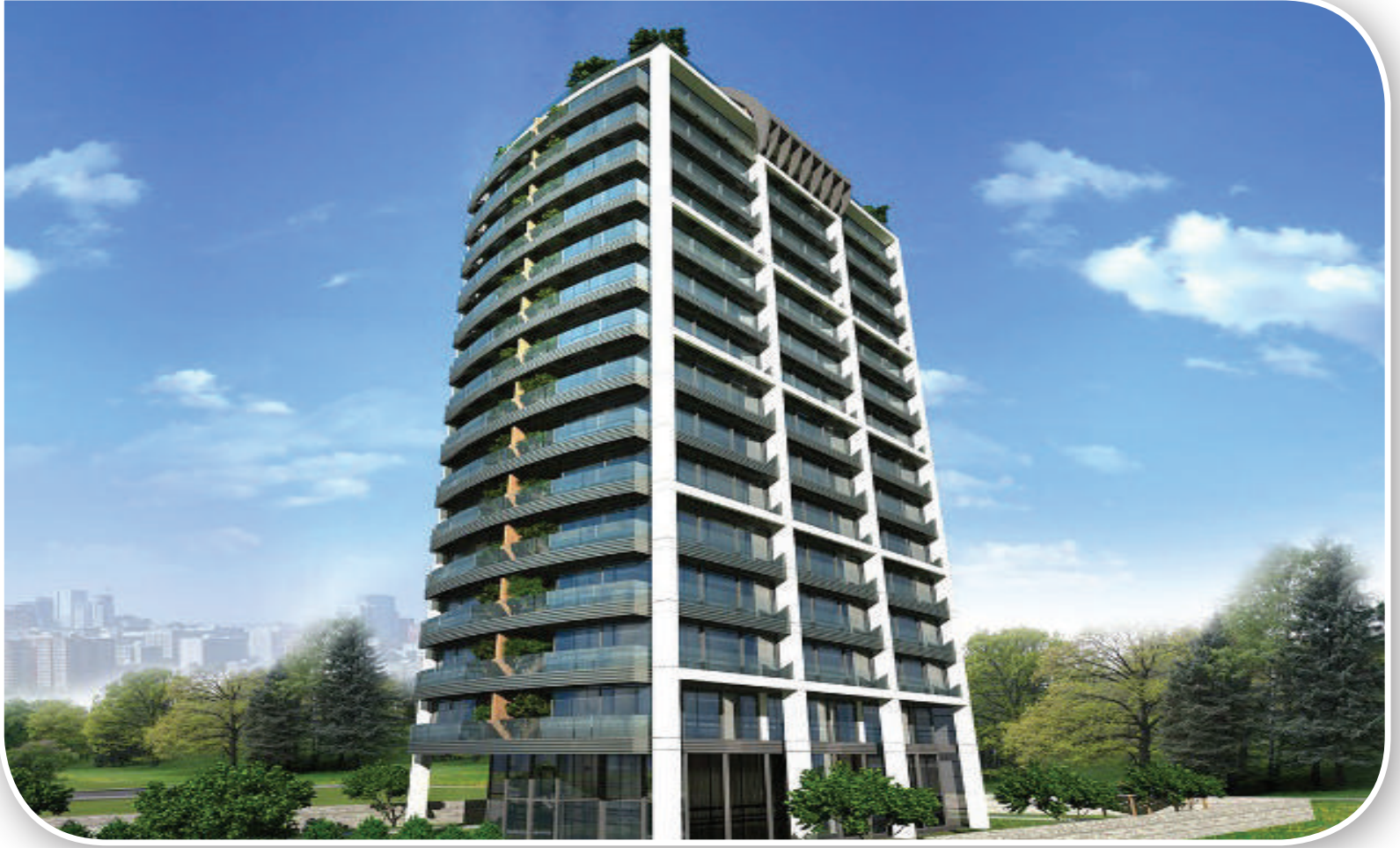
Akbey İnşaat / Artek Apartmanı
